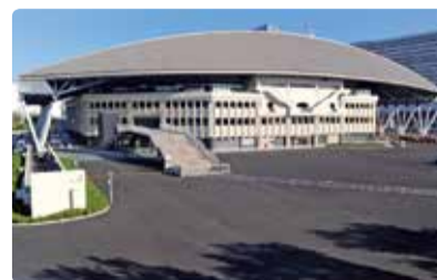
屋根の改修などが行われた「有明コロシウム」
