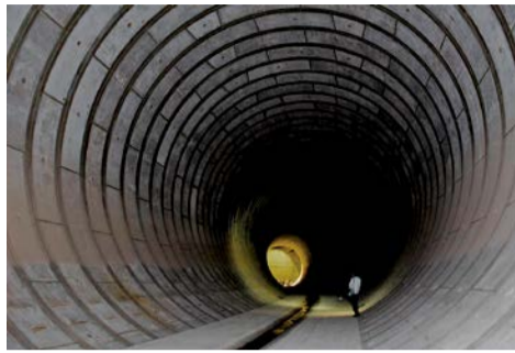
調節池内部の様子
