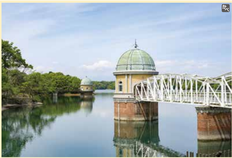
村山下貯水池第二取水塔(左)と第一取水塔
