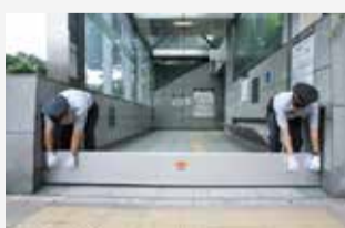
地下鉄出入口に設置する着脱式の止水板
