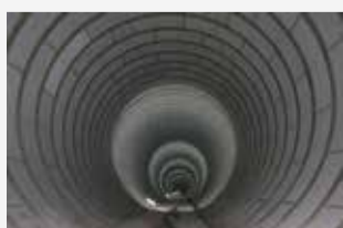
増水した河川の水を貯留する地下トンネル式調節池
