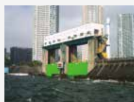
水位観測を行っている水門
