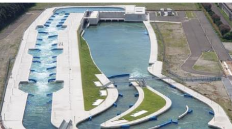
カヌー・スラロームセンター
